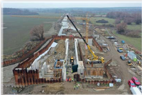
Stavba plavební komory na Baťově kanálu
